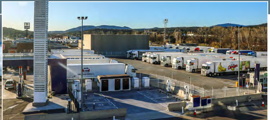
A la derecha, instalaciones de Andamur en La Junquera; abajo, las obras de Andamur San Román II (Álava).
